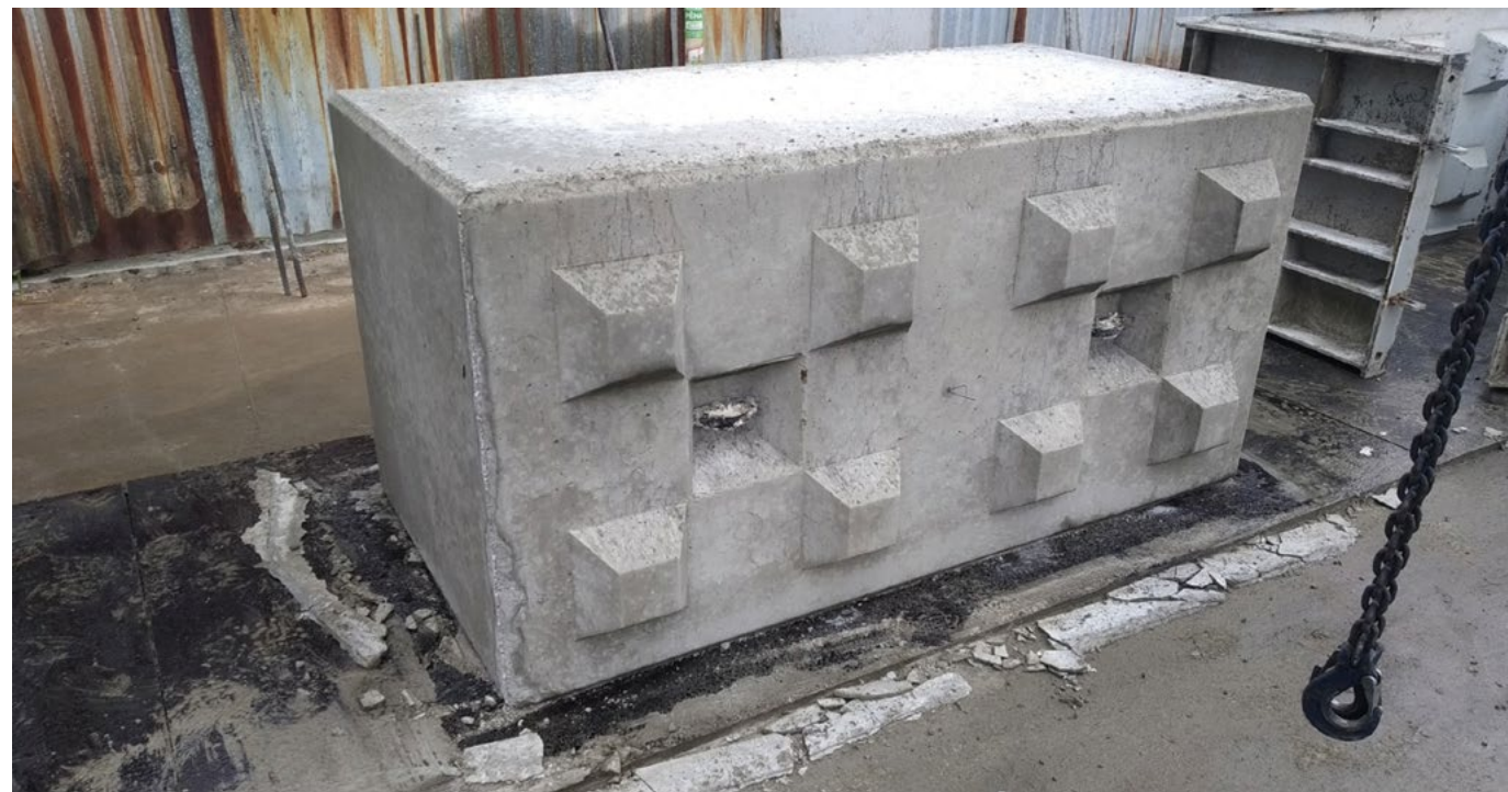
Obr. 1: Uchycení betonových bloků – oka
