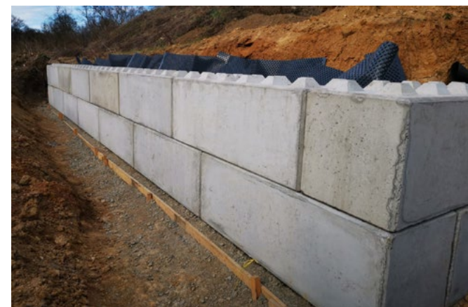
Obr. 7: Realizace opěrné stěny z betonových bloků
