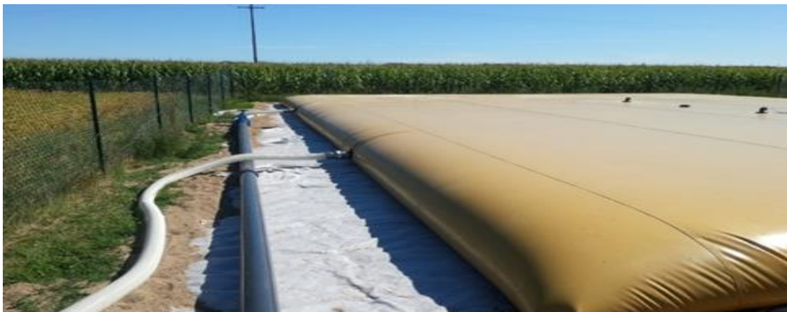
Obr. 3: Flexibilní nádrž se zásobou dešťové vody
