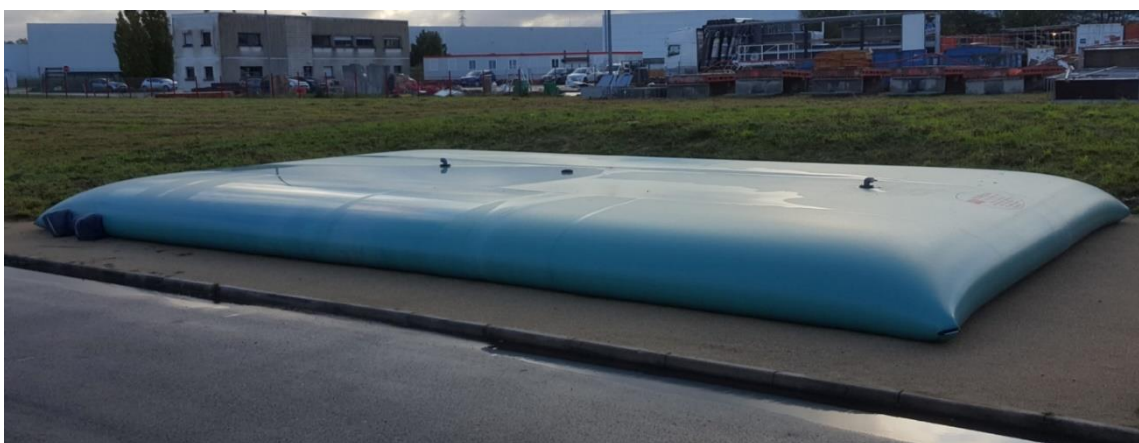
Obr. 5: Flexibilní nádrž se zásobou dešťové vody pro automatické zavlažování
