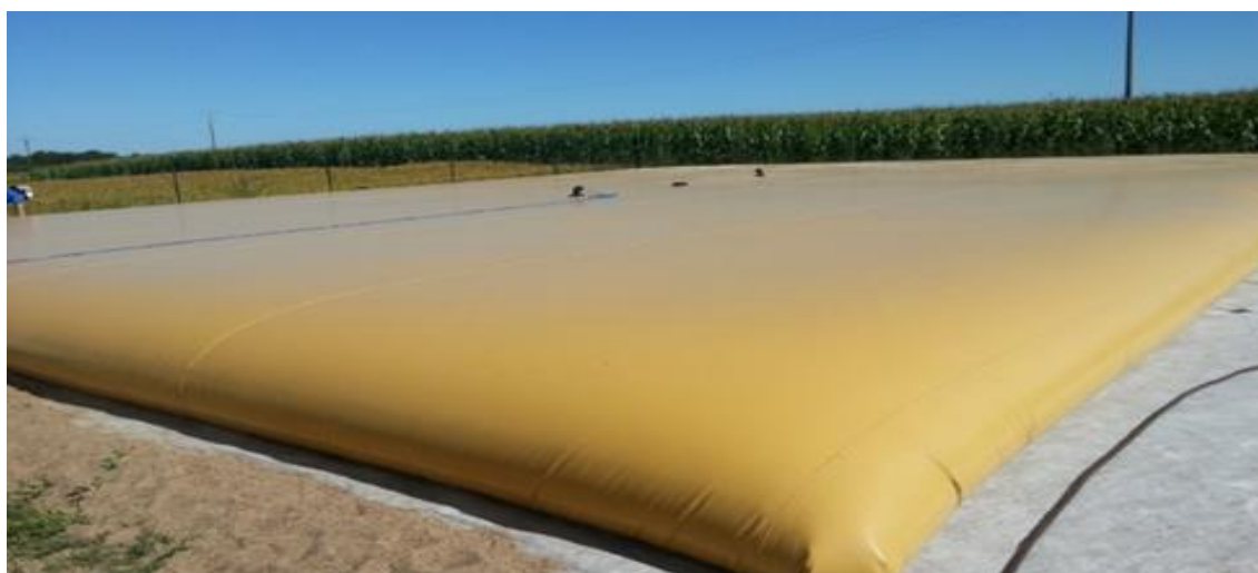
Obr. 2: Flexibilní nádrž se zásobou dešťové vody
