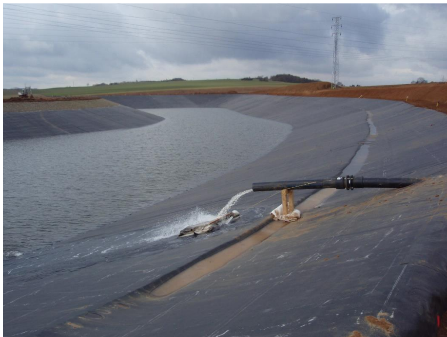
Obr. 1: Malá vodní nádrž Vysoký Újezd u Berouna, těsnění EPDM geomembránou, objem 60 000 m 3
