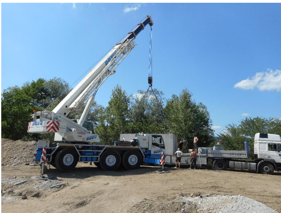
Obr. 2: Betonová prefabrikovaná nádrž, FC Trenčín, Slovensko – objem 80 m 3
